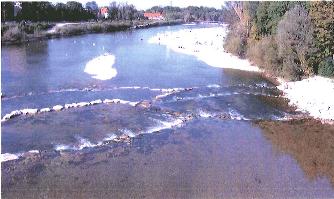
Abb. 8: Aufgelöste Sohlschwellen in Riegelbauweise an der Isar im Stadtgebiet von München (Foto: Bernhart)
